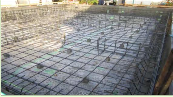
1・D13鉄筋を20センチ間隔で組みます。鉄筋の下に敷かれているサイコロの大きさは一辺7センチで、コンクリートの被り厚さを確保します
