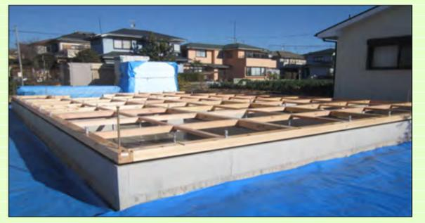
6・ボルト位置を計算して土台に穴あけを行います。水平±1.5mmの誤差しかないので、高さ調整無しで基礎パッキンを挟めます。素晴らしい仕上がりです。
