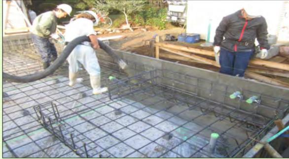
2・地盤下30センチまでセメントを流します。先に塩ビの筒を入れる事で、後から鉄筋を切ることなく配管作業が出来ます。後施工は要注意です。
