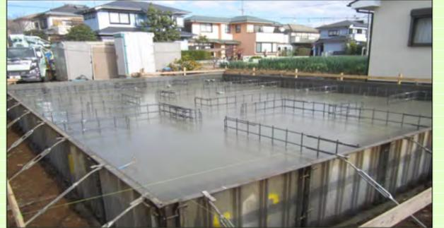
3・数日あけて立上り部分の型枠を組みます。コンクリート厚は17センチあり、家の荷重を底板全体で受け止め、負荷を分散して建物を支えます。
