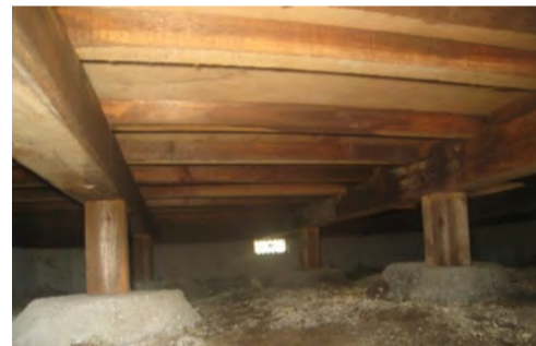
●内部点検：土台・床下 撮影写真
