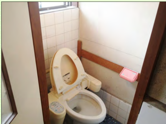
施工前：男女別のトイレなので窮屈に感じていました。
