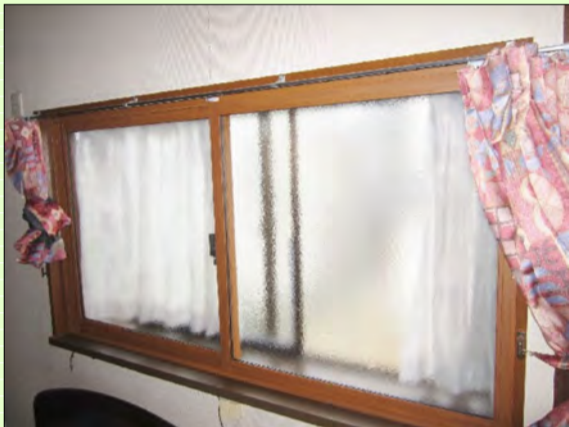
施工後：結露対策と外の音が小さくなりました。
