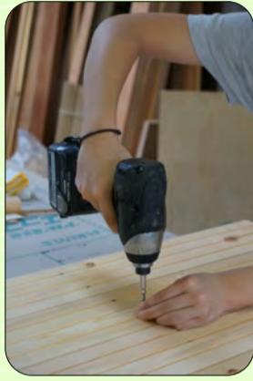
●水性ペンキで塗装をしてから電動ドライバーで組立ます。
