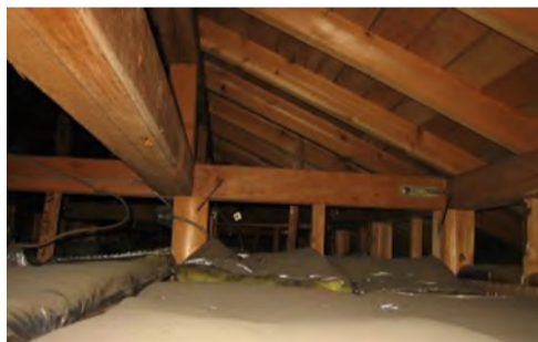
●内部点検：天井・小屋組 撮影写真
